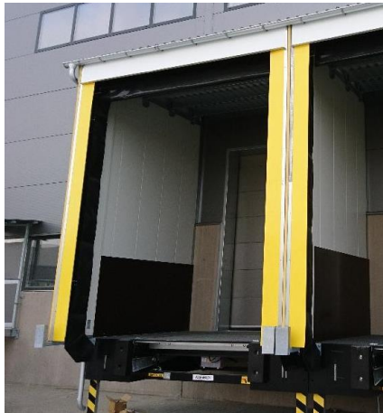
Figur 7 Bild på en uppblåsbar vädertätning på en autodock. Bilderna används med tillstånd från ASSA ABLOY
